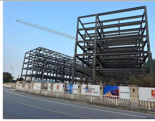
1#厂房、6#厂房施工位置
