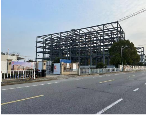
1#厂房施工位置
