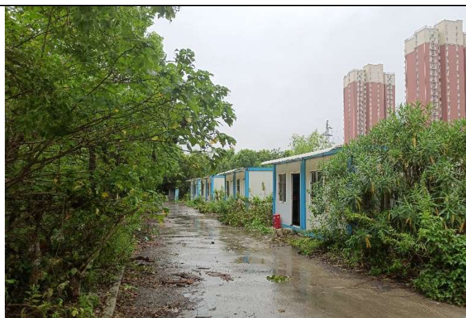
场地南部林地及公路养护周浦道班工房（2020 年）
