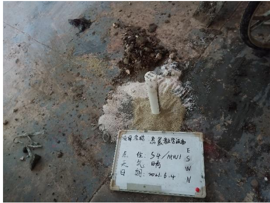
回填石英砂作为地下水过滤层
