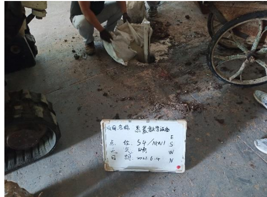
回填膨润土封孔
