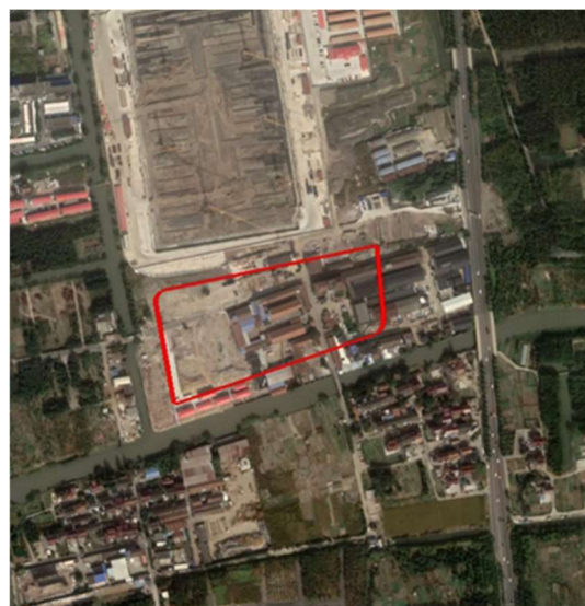
图 1.8-2 场地拆除期间地貌（2019 年）
