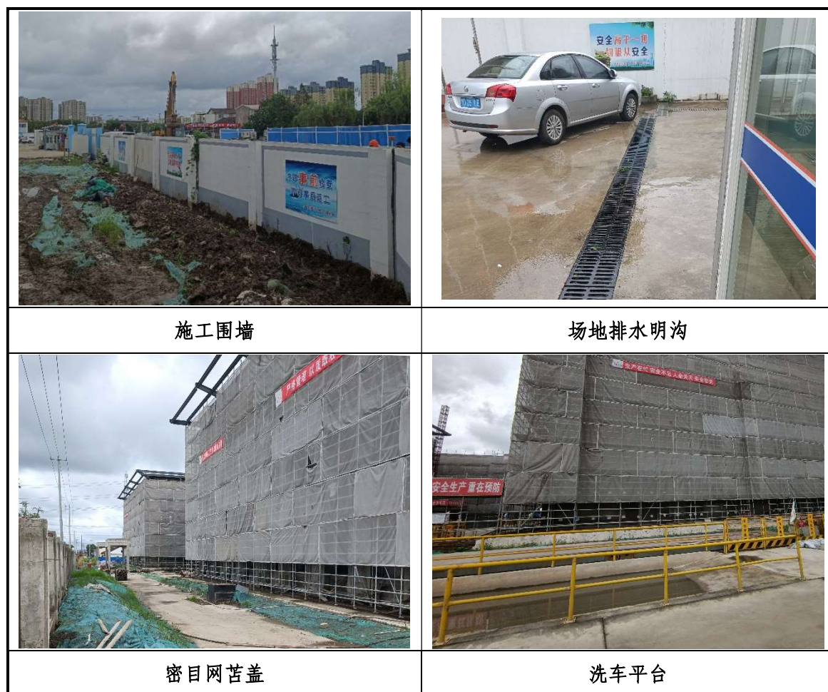
图 2.2-2 施工过程中已落实水土保持措施照片
