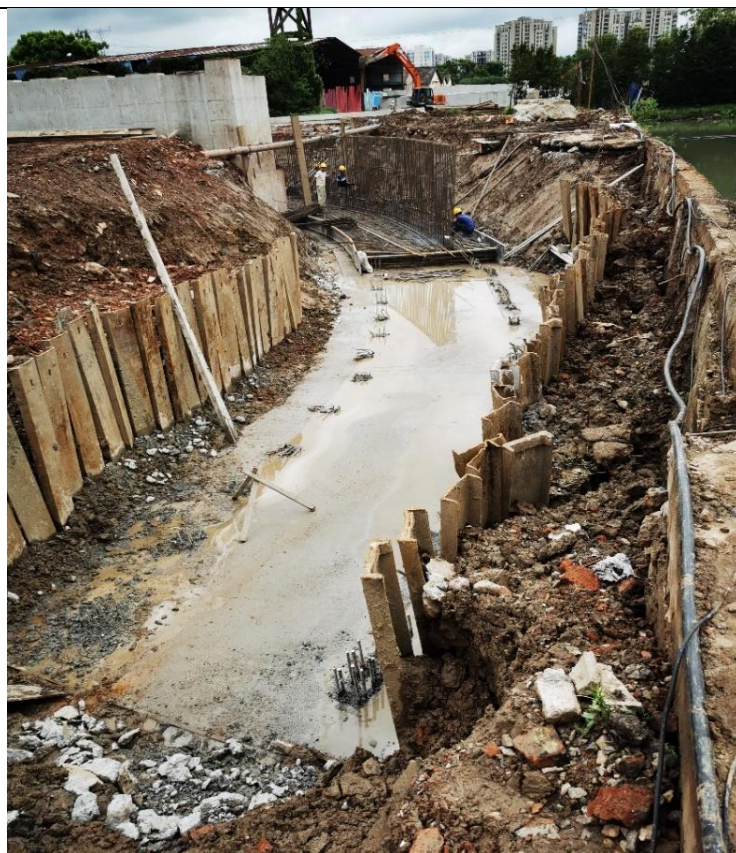
六灶港桥位处泥浆池
