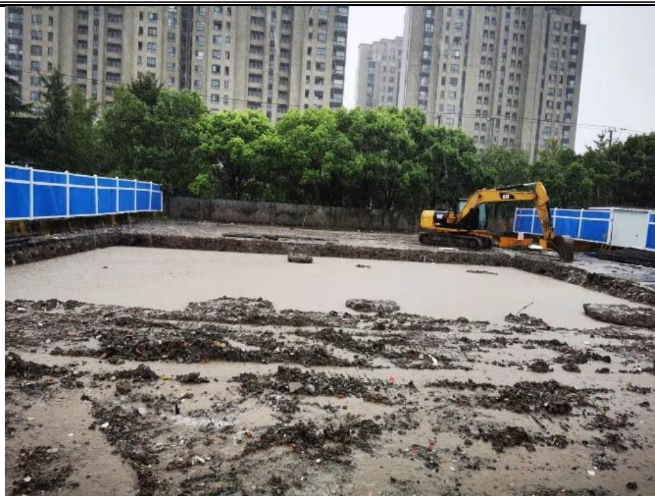
小沥港桥位处现状
