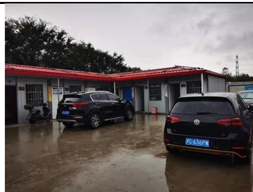
施工生产办公区现状
