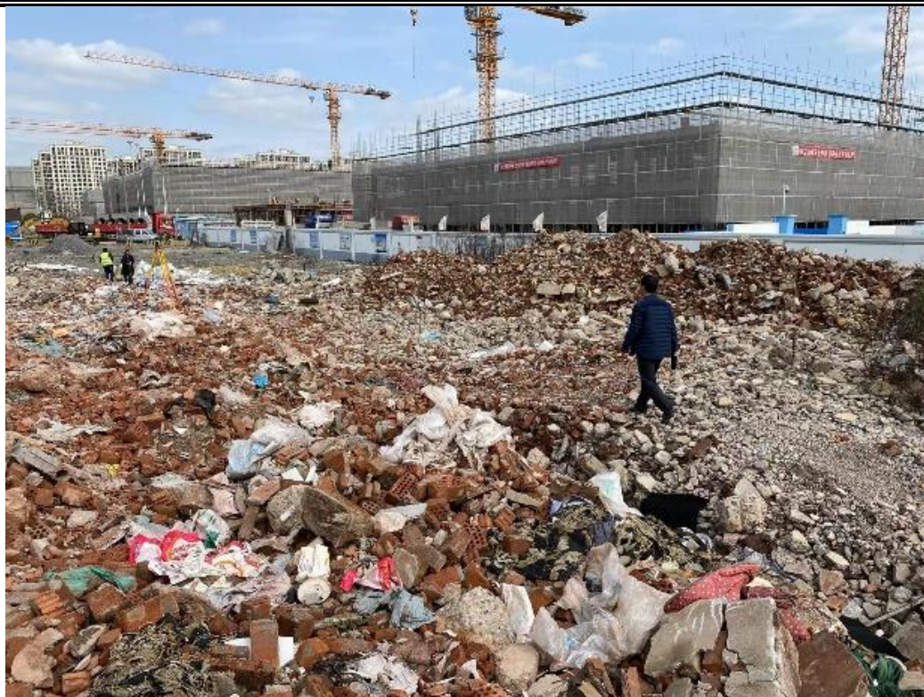
六灶港临时占地（北段）施工前
