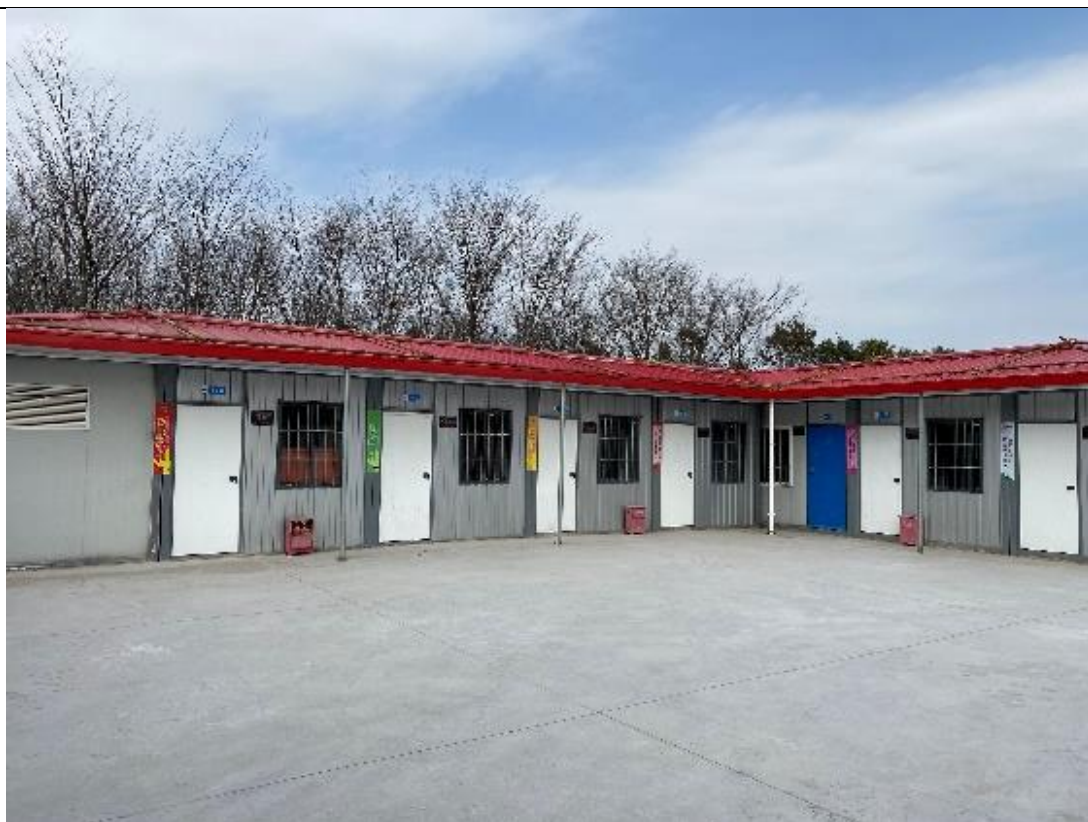
施工生产办公区
