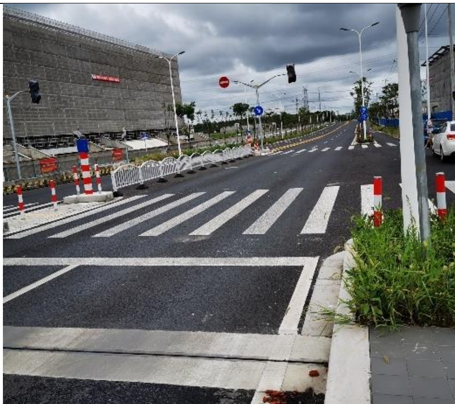
终点繁荣东路段现状图
