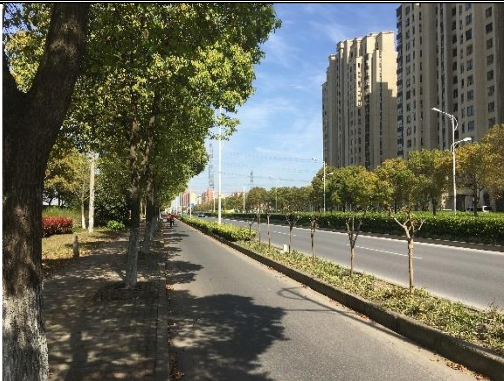
起点周祝公路段现状图（施工前）
