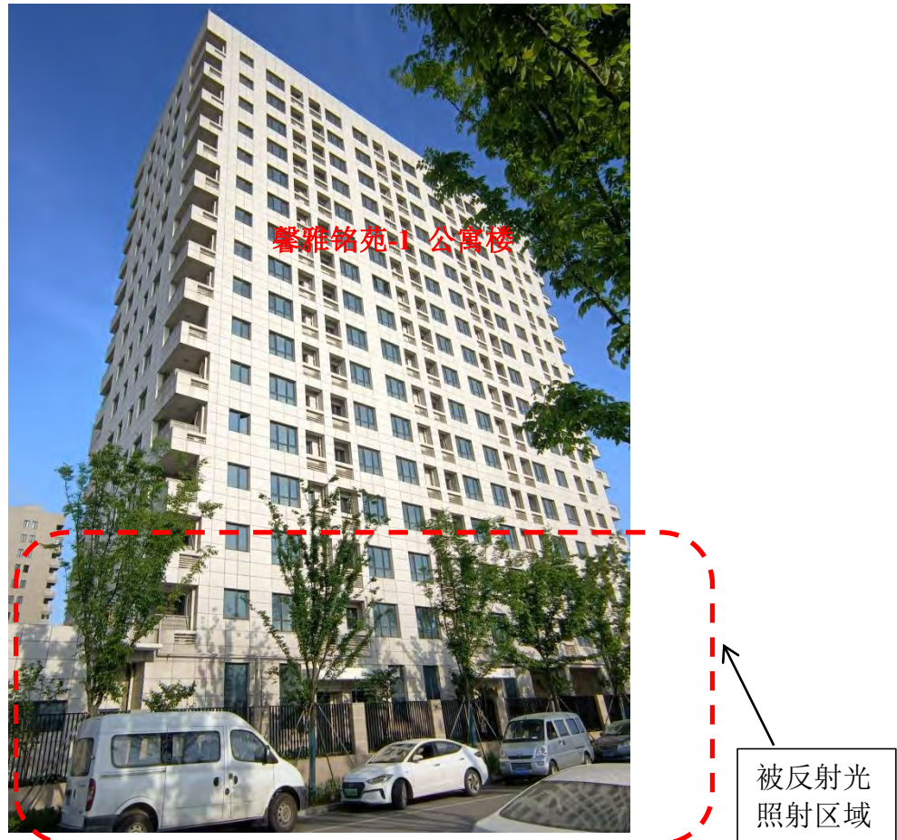
图 5.4.1.3-3 馨雅铭苑-东立面“被照射部位”现场照片
