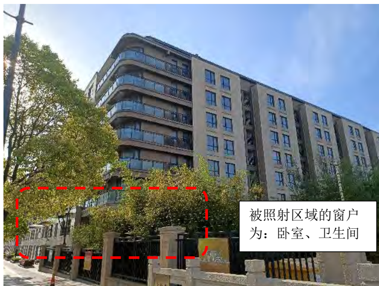
图 5.4.1.4-3 馨悦名邸-东立面和南立面“被照射部位”现场照片
