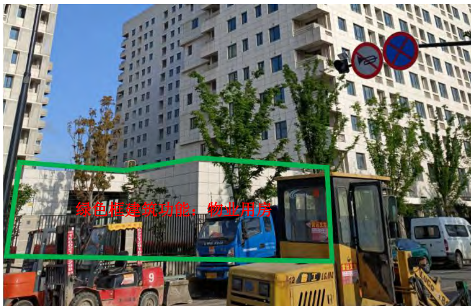
图 5.4.1.3-4 馨雅铭苑-门卫、物业用房“被照射部位”现场照片
