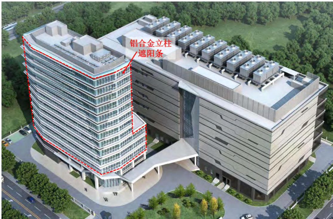
图 5.5-1 2#楼立面玻璃幕墙铝合金立柱遮阳条分布示意图
