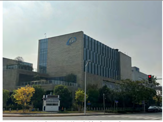
星地通通信科技有限公司
