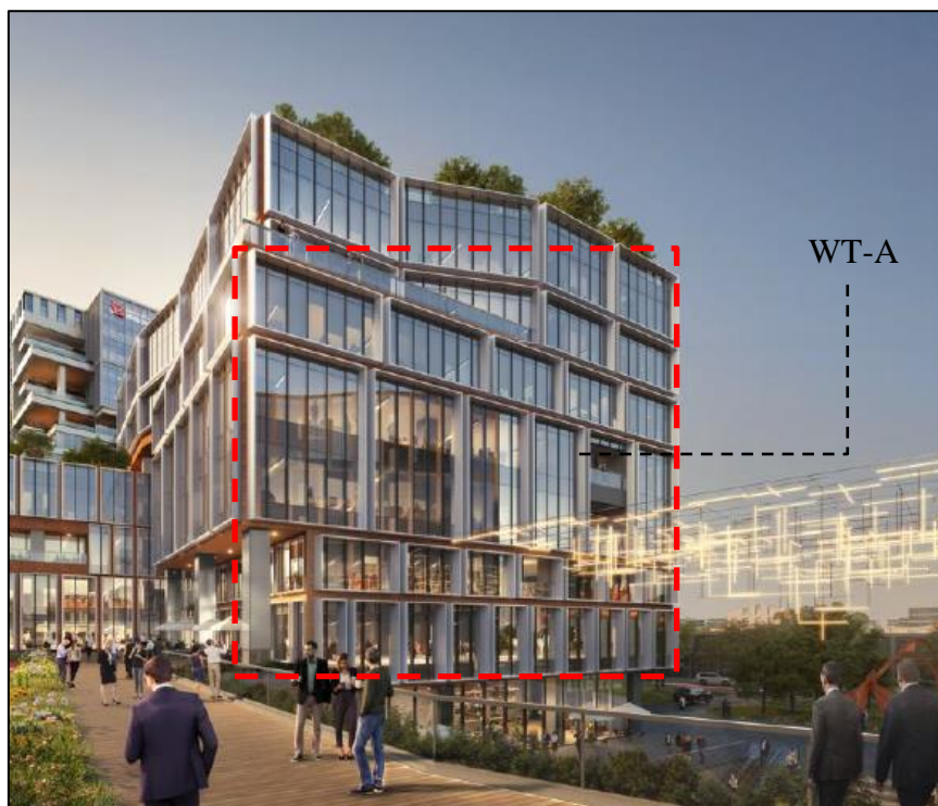
图 5.3-1 T4#楼-南立面 WT-A 半隐框框架系统（带横竖装饰条）幕墙系统
